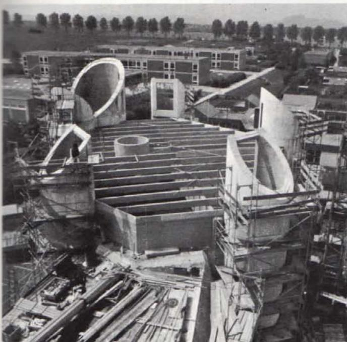
Gesamtansicht der neuen Pfarrkirche. Im Bildzentrum erkennbar die Oberlichtkonstruktion  $\varnothing$  3 m als integriertes Teil der Brettschichtholzträger des Kirchendaches.
