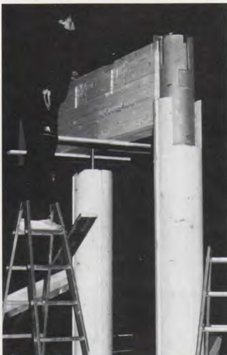
Bild 3: BSH-Stützen: »Stahlkopf« und Dollen.
