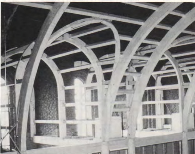
Bild 7: Das Tonnengewölbe im Rohbauzustand.
