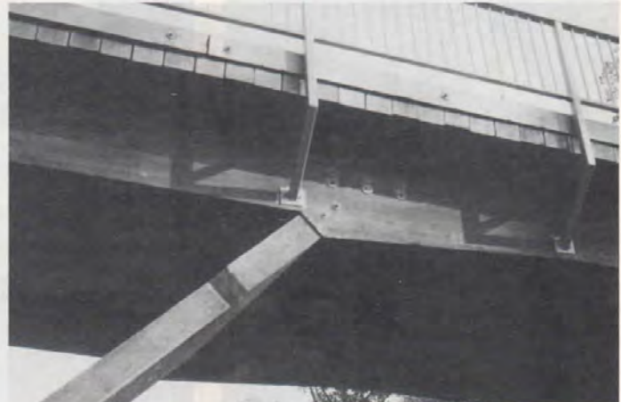
Bild 24: Teilansicht des fertigen Bauwerks
