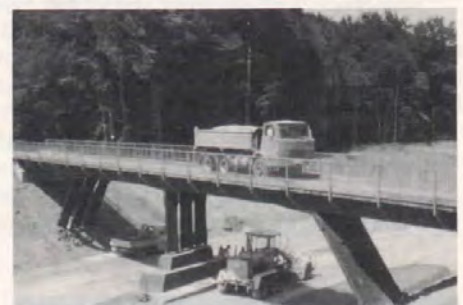
Bild 22: BW 8, für den Verkehr freigegeben
