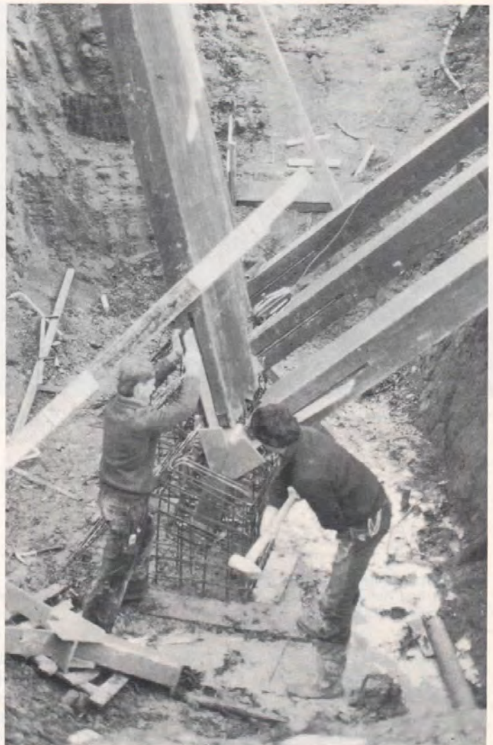
Bild 16: Nur die Stahlteile des V-Stützenfußes wurden auf der Baustelle montiert. Anschließend wurde der Fundamenthöcker betoniert.
