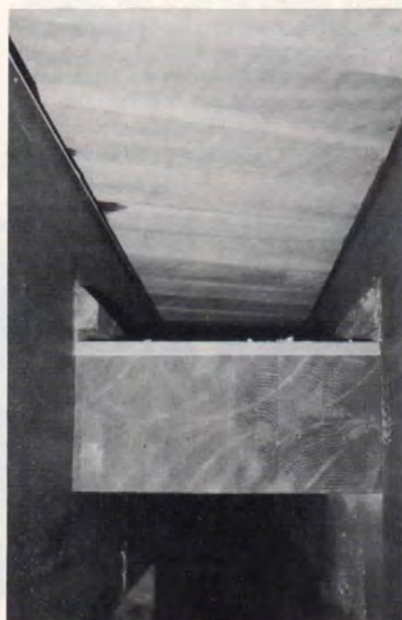
Bild 18: Holzschutz der Hauptträger und Bindehölzer durch Blechabdeckung
