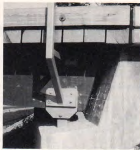
Bild 11: Paßbolzen- und Stabdübelanschluß des festen Brückenaufagers.
