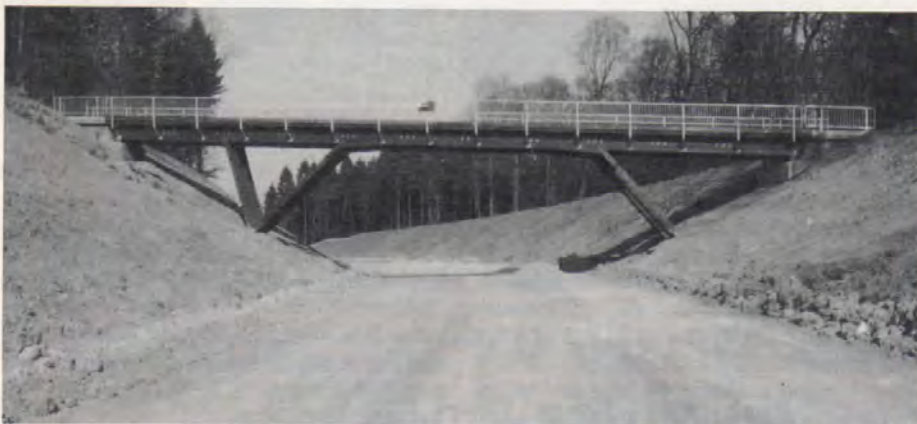
Bild 2: Die Straßenbrücke BW 7 für den forstwirtschaftlichen Verkehr über die Bundesstraße B 295 wurde 1984 erbaut.
