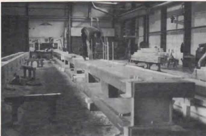
Bild 23: Die Trägerpaare werden im Werk komplett vormontiert.
