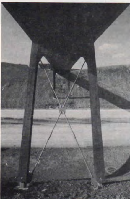
Bild 26: Untersicht BW 9, Anordnung der vier Hauptträger und der schrägstellenden Stützenjoche.
